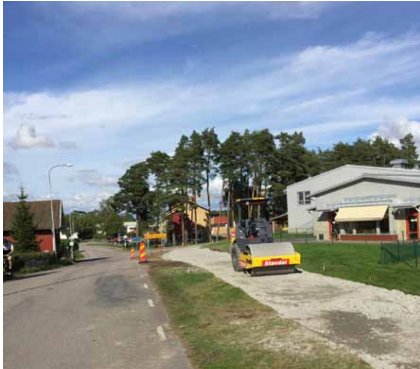
Nu är bygget av cykelvägen mellan skolan och Kedumsvallen i full gång
