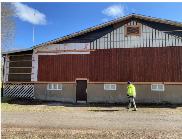
När brädfodringen byttes ut såg man tydliga spår efter hur huset tidigare sett ut.
